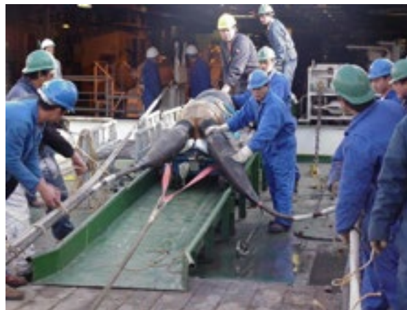
Рис. 8 – Рабочие готовятся к прокладке кабеля
