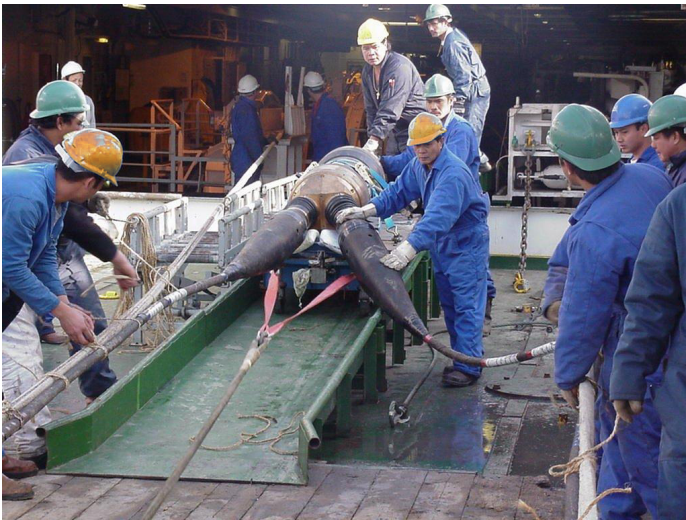
Рис. 8. Рабочие готовятся к прокладке кабеля
